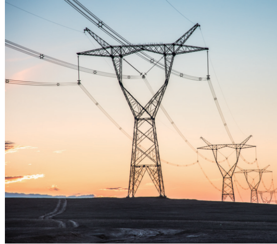
Inspección de Sistemas Electricos
