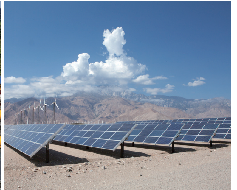
Inspección en granjas Fotovoltaicas/Eolicas
