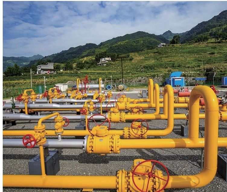
Inspección de ductos Petroquimicos
